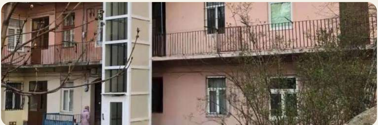
Рисунок 1.33. Приклад прибудови ліфта до галерейного будинку
